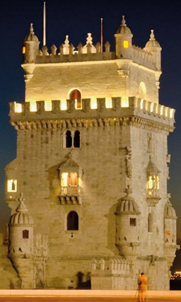
Torre de Belén, Lisboa
